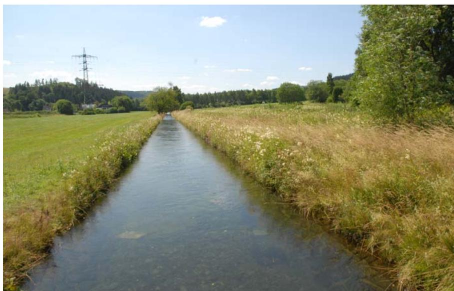
Abbildung 4: Geradlinig geführter und kanalartig ausgebauter Abschnitt der Sorpe unterhalb der Straße „Am Lindhövel“
